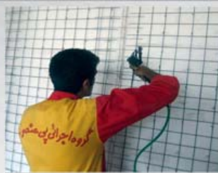
اجرای عملیات نصب پانل و شاتکریت
