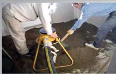
اجرای عملیات کف ریزی طبقات
