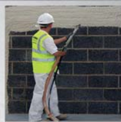
اجرای عملیات گچ پاشی
