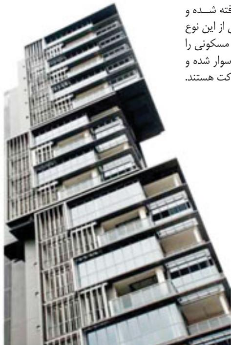
در واقع می توان گفت از جدیدترین علم تکنولوژی ساخت برای طراحی این پروژه استفاده شده است، به گونه ای که ورقه های کامپوزیت استیل، آهن و پلی پروپیلن با ظرافت خاصی در میان بلوک های متحرک قرار گرفته اند که هم هدایت گر حرکت آنها هستند و هم در حین سبک وزنی استحکام ساختمان را دوچندان افزایش داده اند. تراس های این ساختمان نیز رو به آسمان طراحی شده و زوایه تند لبه این تراس ها در یک راستا رو به آسمان شکل گرفته است.
